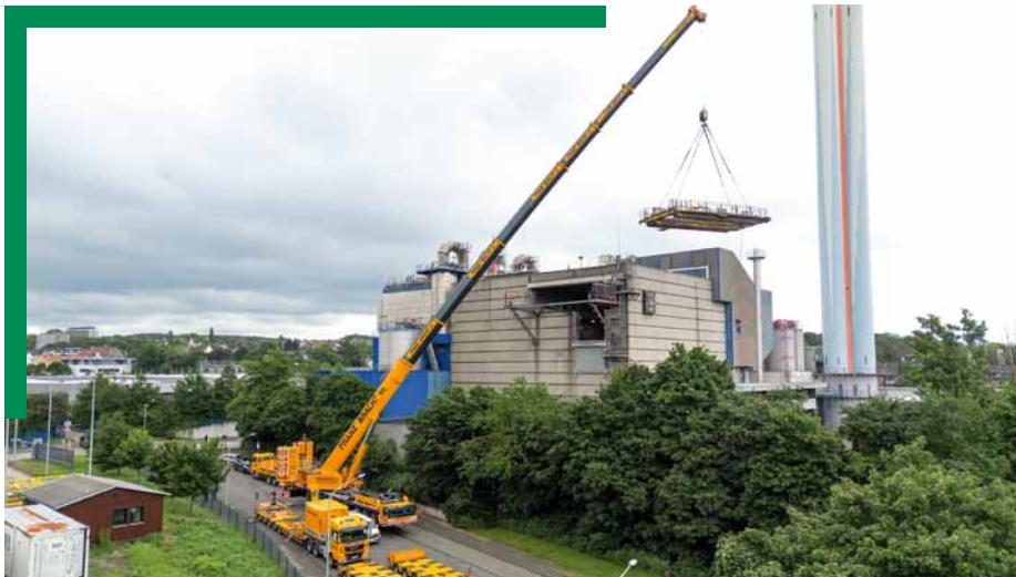
Austausch der Kranbrücke am Müllbunker der MVA.
